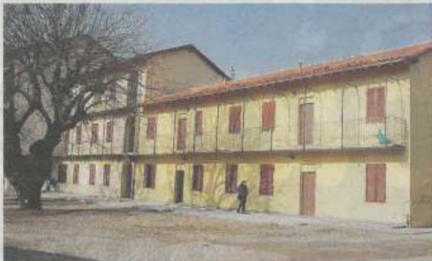
Le nuove abitazioni che saranno consegnate sabato 15
